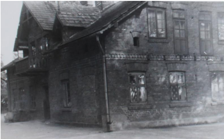
Budynek szkolny w Okupie Małym. Mieściła się tu jedna izba lekcyjna oraz mieszkania dla czterech rodzin nauczycielskich.
